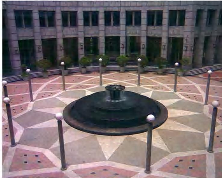
Terdapat 12 pilar (yang menjadi ujung dari 12 sudut bintang) di plaza air mancur Bank Indonesia
